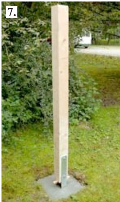
Fertig einbetonierter Pfosten.
